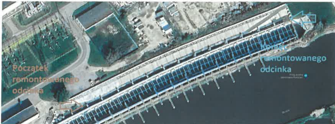
Zdjęcie nr. 1 lokalizacji drogi przeznaczonej do remontu
