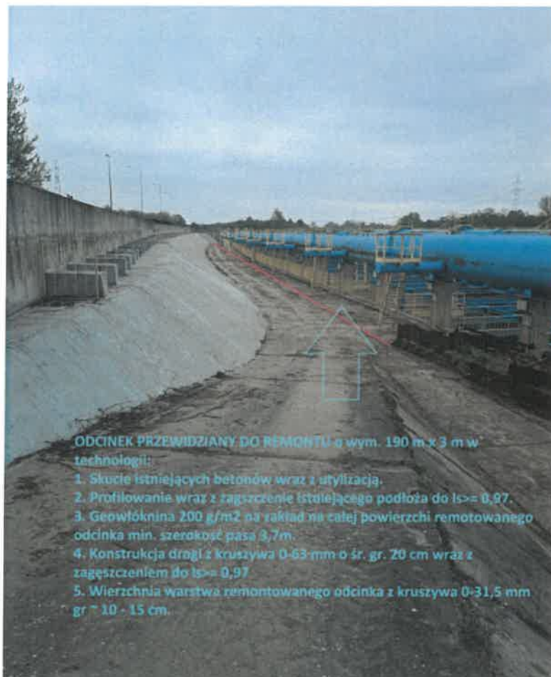
Zdjęcie nr. 2 miejsce prowadzenia robót w kolejność technologicznej
